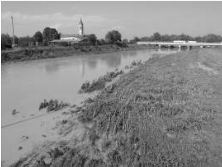
Nure a Roncaglia (Piacenza) – settembre 2015 – Dopo il passaggio della piena
